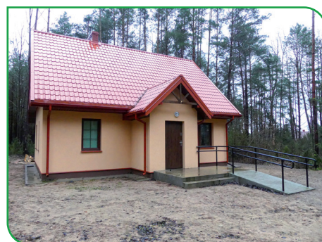
Zbudowana od podstaw świetlica w Nowej Łuce
