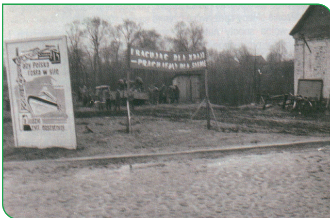
Budowa drogi dojazdowej na „kółko” w 1976 r. Działania wykonano w czynie społecznym tutejszych zakładów pracy. Zdjęcie pochodzi z kroniki Gminy Narewka. Po prawej stronie widzimy młyn wodny, a na pierwszym planie brukowaną nawierzchnię ulicy.
