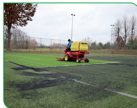
Prace renowacyjne nawierzchni boiska na Orliku w Narewce
