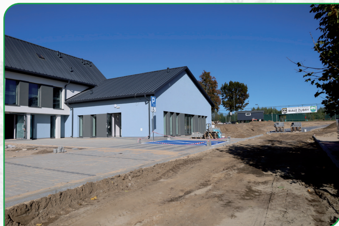
Fot. Powstająca droga dojazdowa do Stadionu oraz nowy obiekt sportowy
