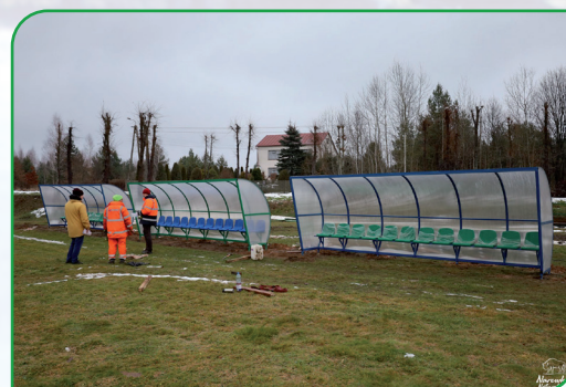
Fot. Montaż wiat na stadionie
