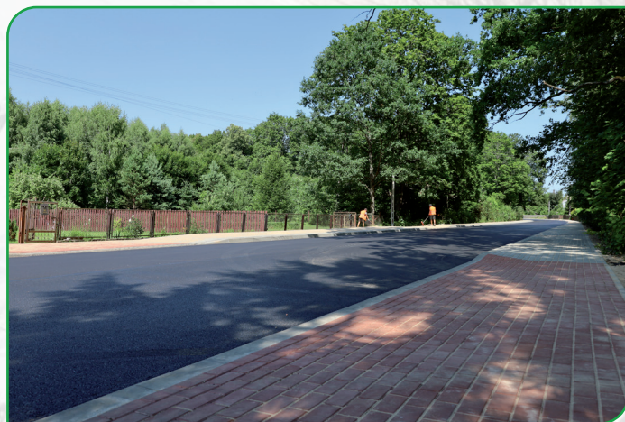
Fot. Nowy chodnik z kostki brukowej w Świnorojach
