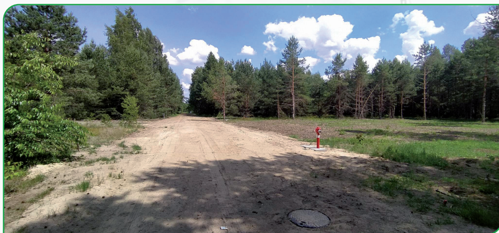
Fot. Instalacja wodno-kanalizacyjna na Nowej Łuce
