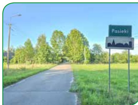
Pasieki. Droga do przebudowy
