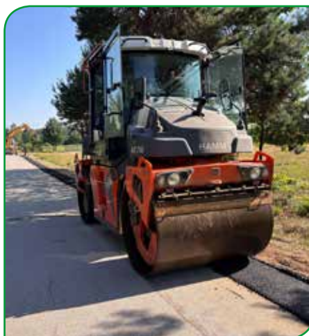
Droga w Krynicy - w trakcie robót
